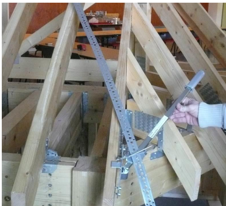
Mettre la goupille pour bloquer le feuillard
